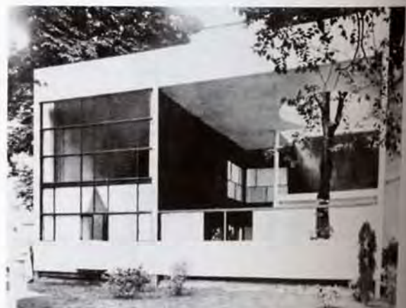
Fig. 566 Le Corbusier, Pavillon de l'Esprit Nouveau .
